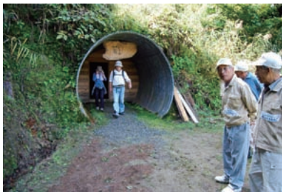
明治時代の洞門を遊歩道に整備した
