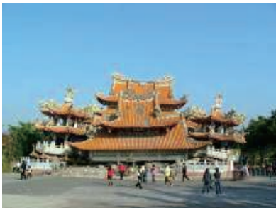
武昌宮：一階部分がつぶれている
