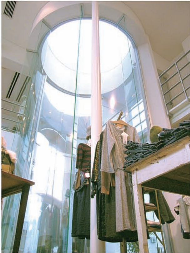
売場から中庭を見上げる
