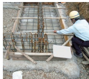
写真7, 8 / 基礎配筋検査 2006 5/11
