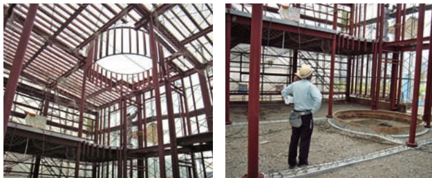
写真 13,14 / 設備配管、サッシ取付け 2006 7/12
