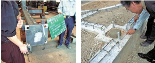
写真 9,10 / 鉄骨検査、現場基礎 2006 5/17
