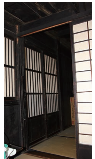
図16 オクノチョウダの背面側 引違い障子戸がササラ子下見板で隠れているが下見板は後から打ちつけられたもの。
