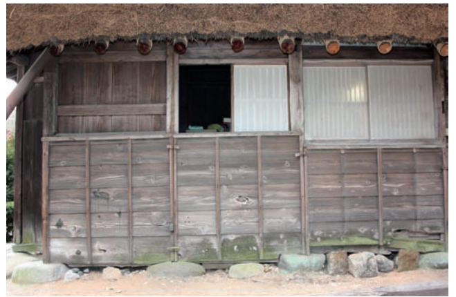
図16 オクノチョウダの背面側 引違い障子戸がササラ子下見板で隠れているが下見板は後から打ちつけられたもの。
