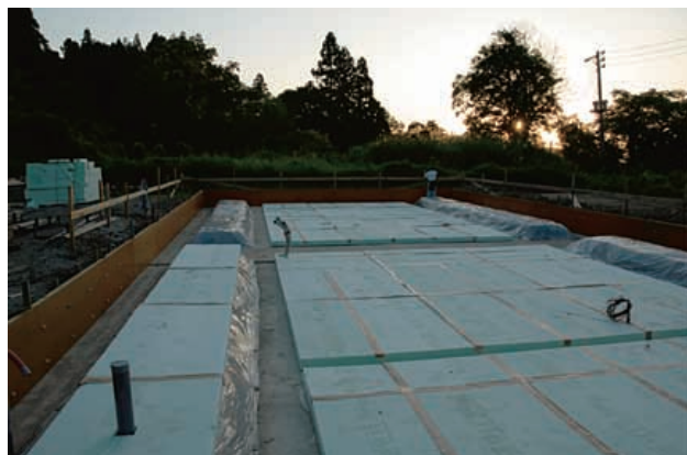
写真6ー基礎下の断熱材の敷き込み
