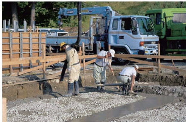
写真5ー捨コンクリート打込み
