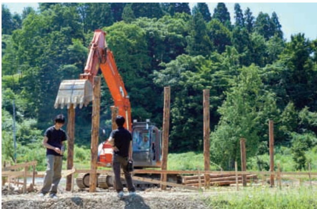
写真1ー松杭を概ね100本打込む
