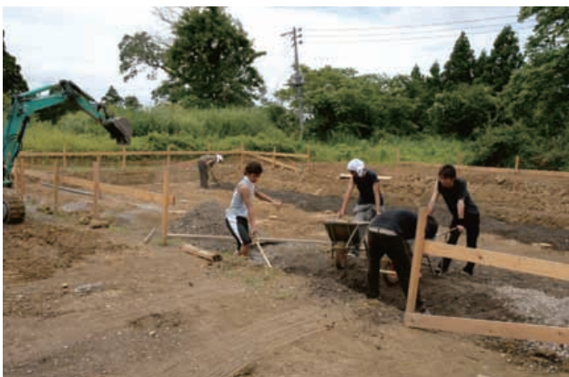
写真3ー地業 (杭頭処理し地業開始)
