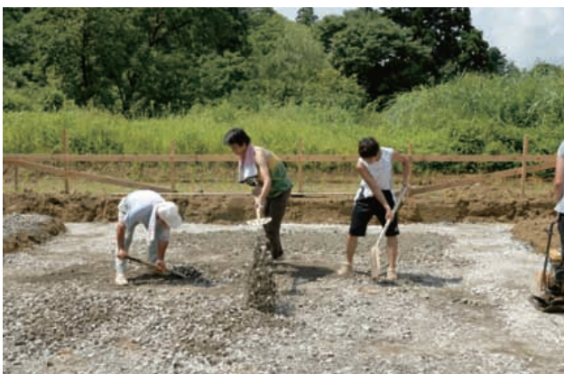
写真4ー地業 クラッシャーラン敷き込み
