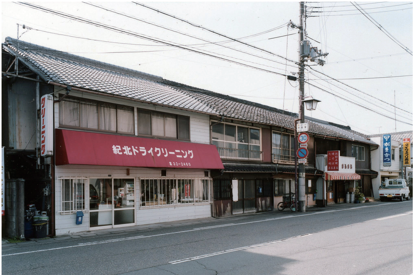
楠本家長屋 北東より 田村収撮影
