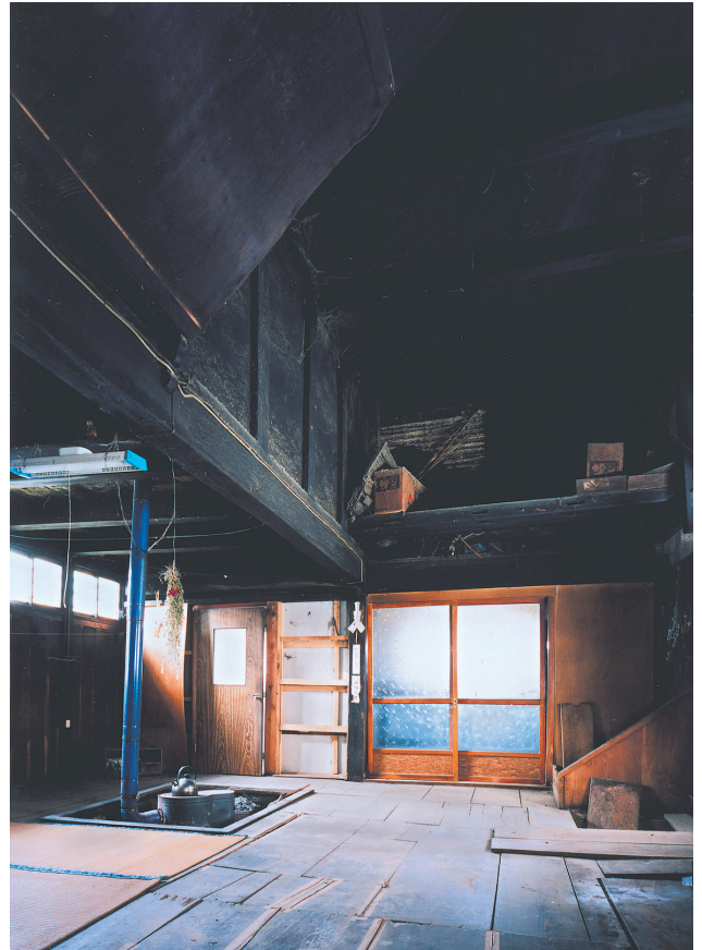
写真4 ダイドコロ 南東より
