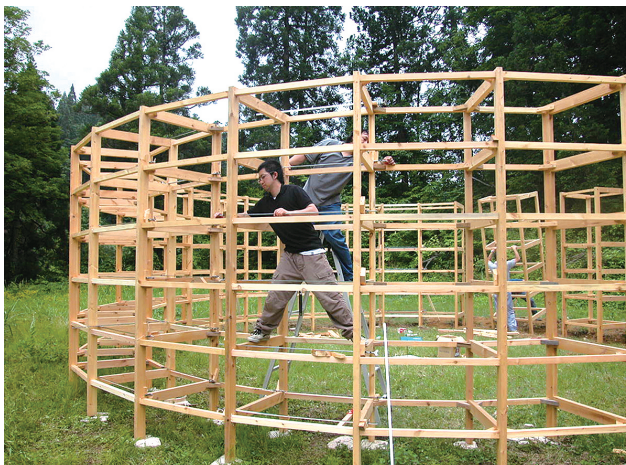
写真9 構造体ユニットの連結
