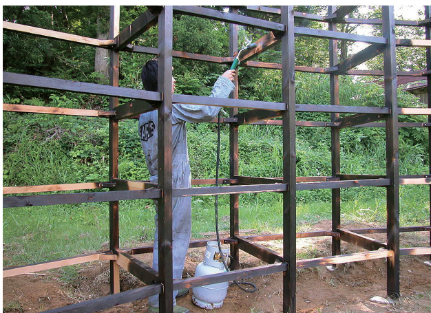
写真10 構造体表面処理
