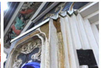
fig.9 (右上) 過去の復元的修理跡と亀裂の充填処置跡
