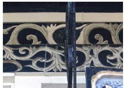
fig.8 (左上) 表面仕上げ層漆喰の剥離と剥落
