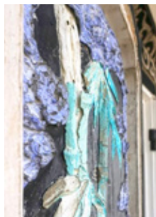
fig.8 (左上) 表面仕上げ層漆喰の剥離と剥落
