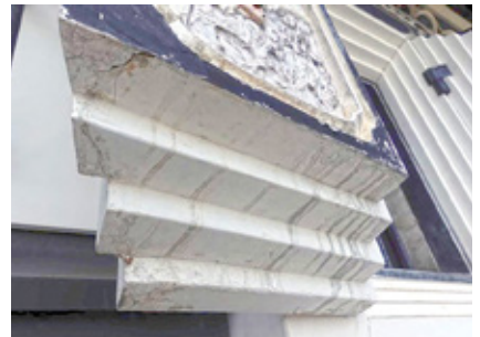
fig.6 (左上) 彩色層の剥落 fig.7 (右上) 溶けて流れ出た黒色顔料
