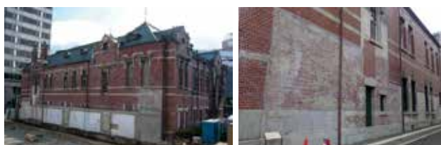
左：写真8 増築部を撤去した状況 右：写真9 北側外壁（現状）
