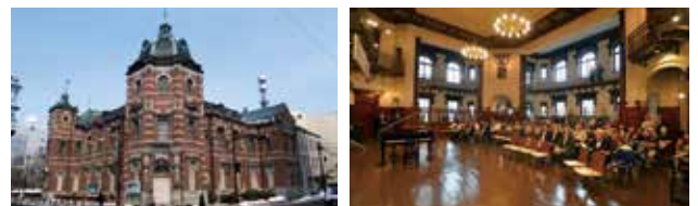
左：写真17 東南からの外観（2016年3月保存修理工事完了後） 右：写真18 営業室（修理後・2016年7月オープニングセレモニー）
