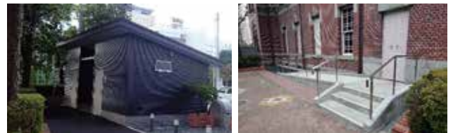
左：写真15 新設した便益施設 右：写真16 段差解消のために新設したスロープと階段
