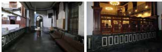
左：写真10 東側客溜（修理前） 右：写真11 同（修理後）
