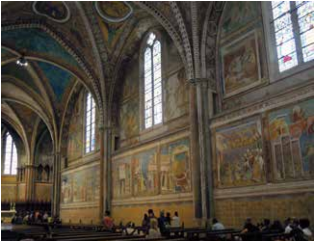
図5：サン・フランチェスコ聖堂、上堂内部、細い柱の束と天井のリブ、控え壁に設けられた通用の小さな開口
