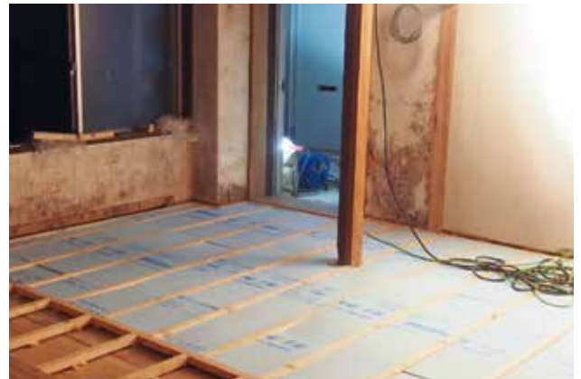
写真6 断熱工事
