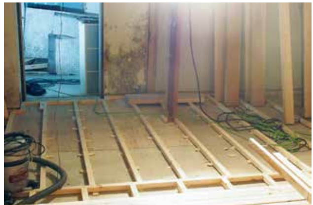
写真5 根太工事
