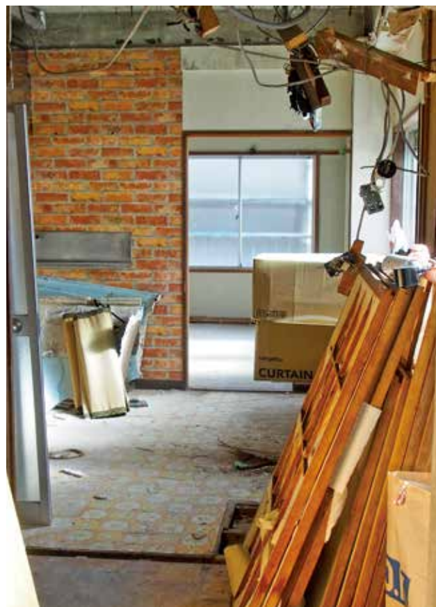
写真2 内部空間の状態
