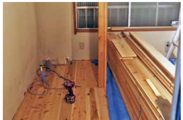
写真7 フローリング貼り
