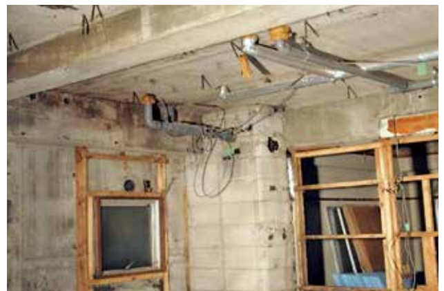
写真8 既存天井をはがした状態
