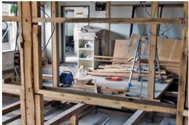
写真4 床レベル調節工事
