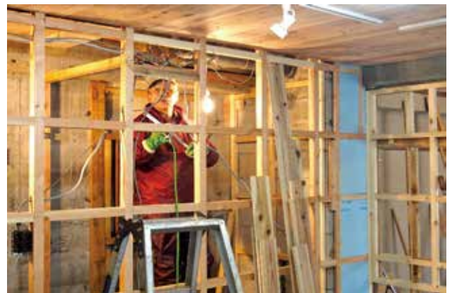
写真9 天井の縁甲板と壁工事
