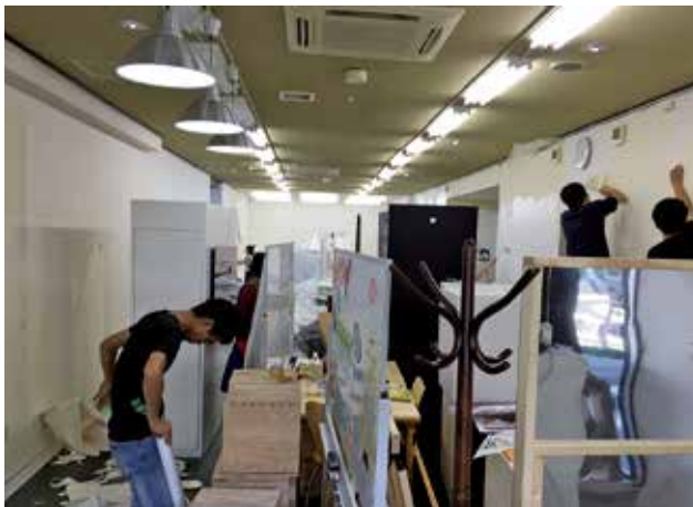
写真1 ホワイトキューブへの改修
