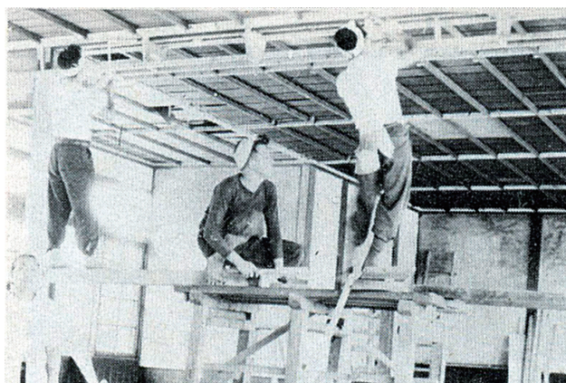
図書室の改装工事
