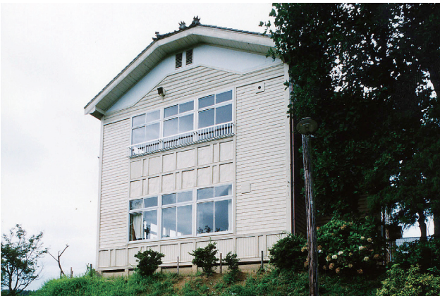
増築した校舎(音楽室、図書室)
