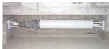
写真 21 免震オイルダンパー例
