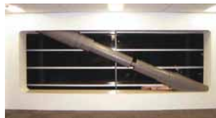
写真 22 制震オイルダンパー例
