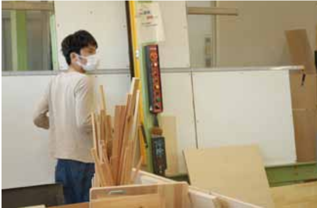
写真8 H25 パネルソーを使ったカット
