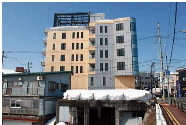
解体されることになったマンション
