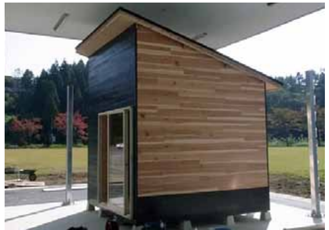
外壁は防水塗装を施し、片流れの屋根とした
