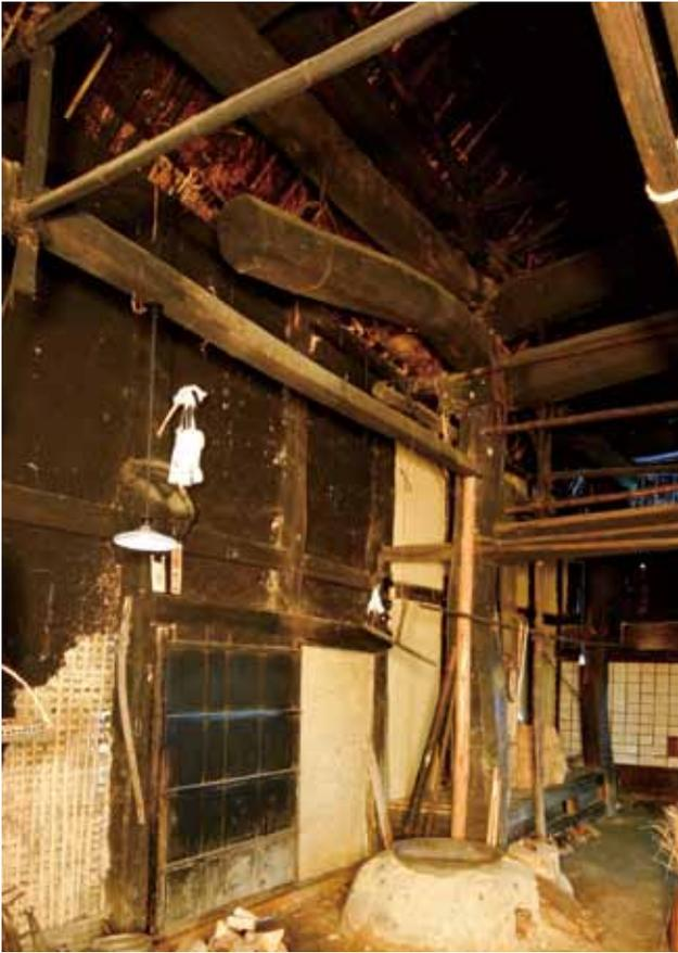
図 16(続き) 村上4「ろ十八ーぬ十八」梁先端が大きく跳ねだしており、木口がみえる
