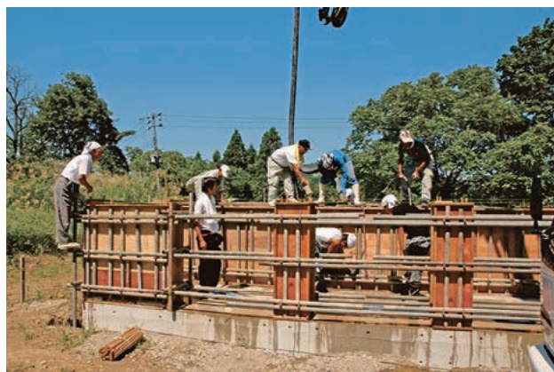
写真2ー1階壁打設—学生の参加は型枠たたき 左で単管に乗っている人が工事の棟梁をしてくれた布川大工さん、実に50年以上の経験者である。型枠の下をたたいているのは建設を担当した学生。
