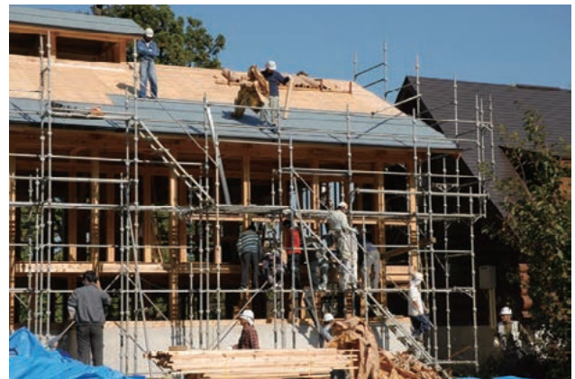
写真11ー屋根ガルバリウム鋼板平葺の下地工事
