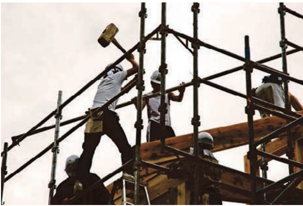
写真6ー棟木の打込み
