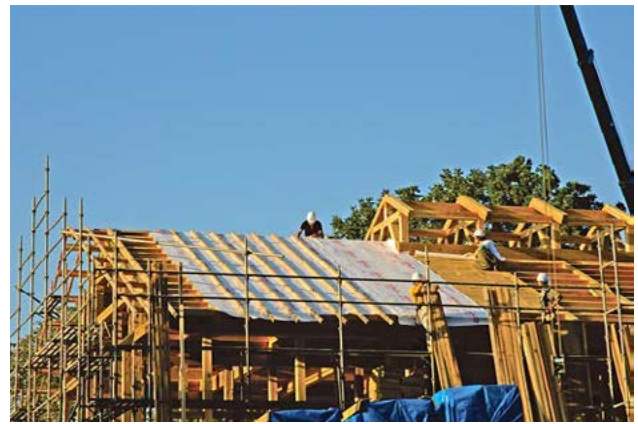
写真10ー屋根の杉皮断熱材上の通気層
