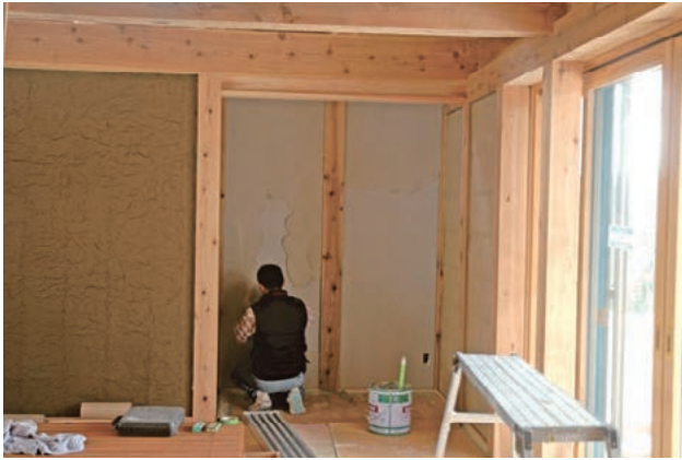
写真 12 - 荒壁としっくい仕上げ
