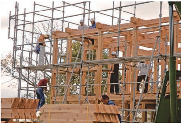
写真5ー2階の柱、梁の建て方
