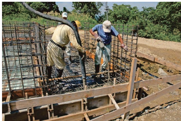
写真1ー基礎打設
