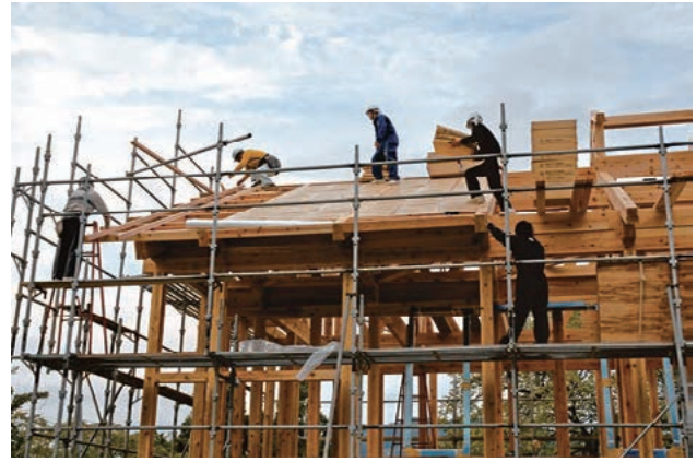
写真8ー屋根の断熱ー杉皮の断熱実験
