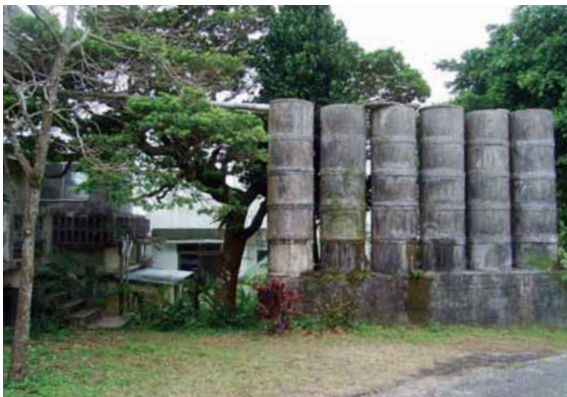
図1-0a 北中城村某家お天水槽一雨水を集める水槽6基
